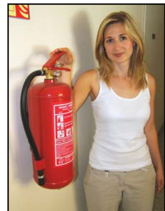
Abb.2: Platzierung des Löschergerätes 150 cm vom Fußboden
