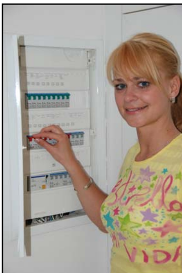
Abb.: Ausschaltug der Hauptschütz des elektrischen Stroms
