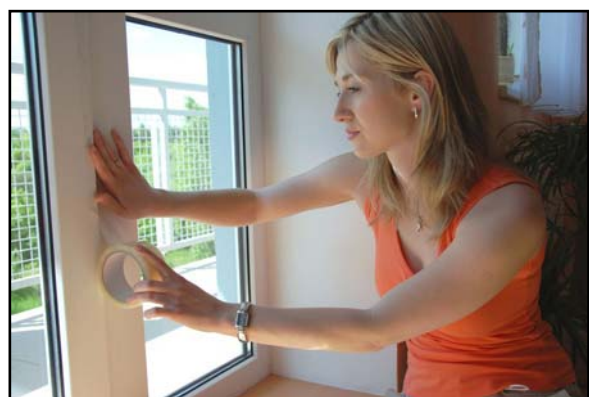
Abb.2: Abdichtung der Fenster mit dem Klebeband
